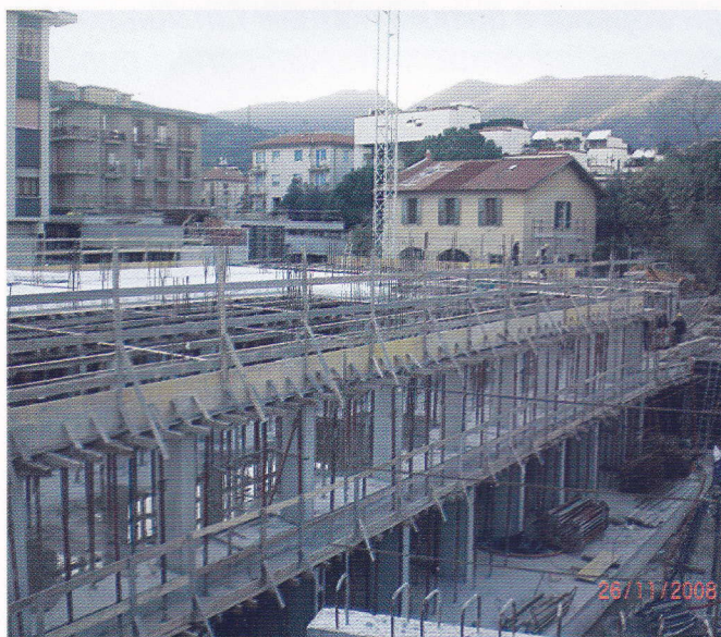
Un'immagine del cantiere del nuovo Municipio
