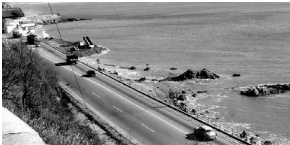
Foto N° 21 Bergeggi 1970 litorale Nord. Si noti la piccola spiaggetta sullo sfondo. Primi versamenti in aderenza.
