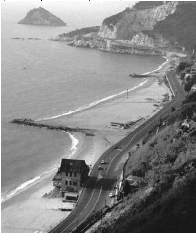
Foto N° 26 Bergeggi 1974. Si realizza il terzo pennello alla Madonnetta.
