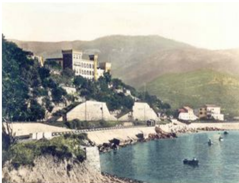
Foto N° 8 Noli Villa Ada 1950
