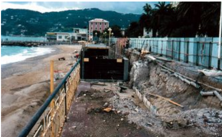
Foto N° 12-1 Spotorno 1984. Lavori sulla passeggiata lungo mare Marconi, con creazione di nuovi spazi per cabine e servizi
