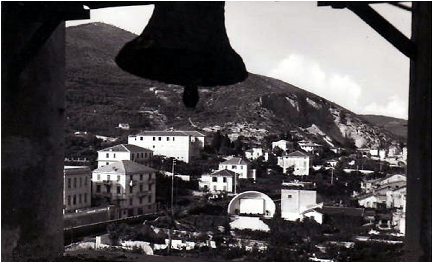
Spotorno, lato levante, visto dal campanile della Chiesa Parrocchiale. In primo piano lo schermo del cinema all'aperto Ariston, rimasto in esercizio sino agli anni novanta; sulla sinistra la massiccia costruzione del Convitto Nazionale Longone e. sullo sfondo, la cava di calce ancora priva di costruzioni.
