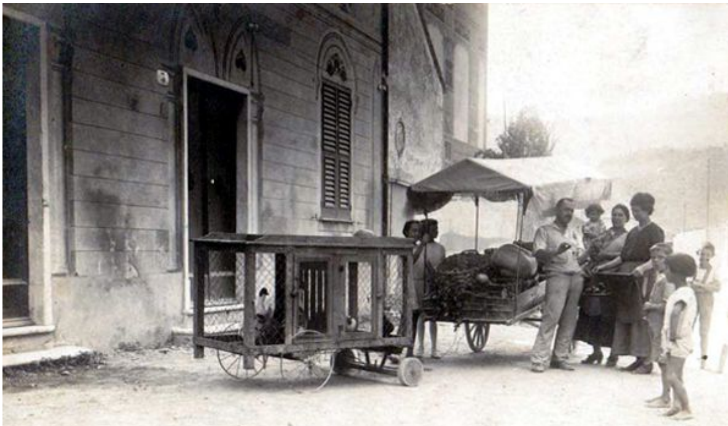
1922 - Largo San Sebastiano, oggi Piazza Galileo; vendita di prodotti agricoli e animali davanti ai portoni del retro di Villa Corinna. A destra si intravede la facciata dell'oratorio di San Sebastiano e la palazzina dei Signori Rosso. La Chiesa, posta a ponente dell'abitato di Spotorno, come la chiesa di San Rocco, posta a levante, erano dedicate ai santi protettori contro la peste.
