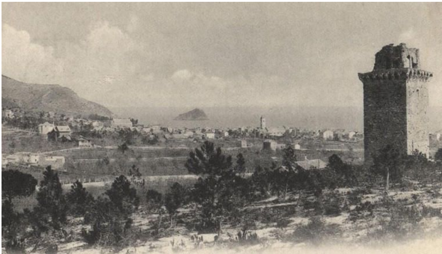
Torre di avvistamento di ponente, detta del Coreallo , prima del restauro. Vigilava sulla costa per allertare in tempo utile la popolazione in caso di sbarchi saraceni.
