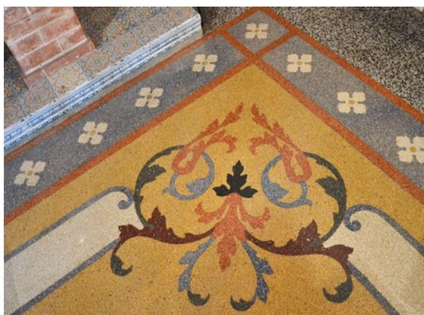
Da capitolato “... per i **pavimenti alla veneziana** si doveva procedere: alla stuccatura delle fessurazioni con colori e pietre della stessa intensità e qualità di quelli esistenti, ripristino delle parti deteriorate, sostituzione di quelle mancanti....”
